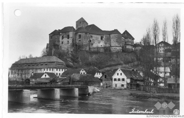
Slika 8: Grad pred obnovitvijo
